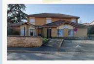
Régénération bâtiment de la Police Municipale (Rue du Cinier) - 2021 301.097 €
