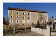
Rénovation Immeubles TA et privatisation parking - 2023 1.163.540 €
